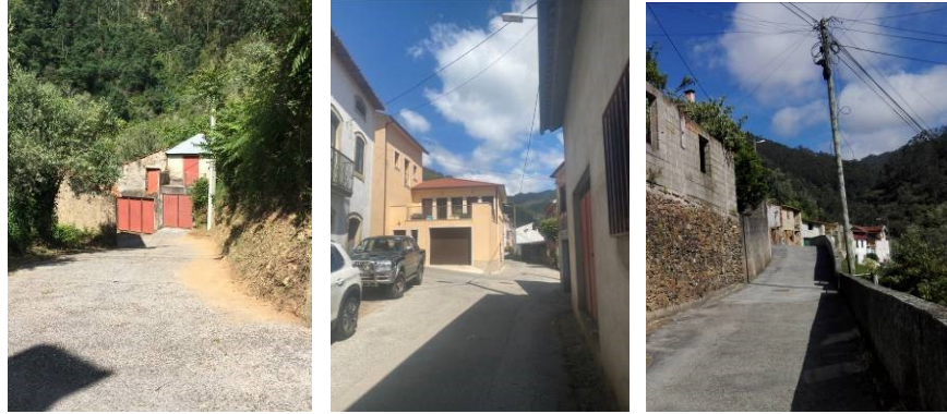
Exemplos de infraestruturas de circulação principalmente viária: I02- Rua do Seladinho, I06- Rua da Liberdade, I15- Rua do Bacelo
