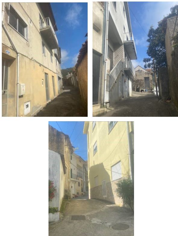
Exemplos de infraestruturas de circulação principalmente pedonal: I07- Rua da Lomba, I08- Rua das Lapas, I09- Rua da Capela
