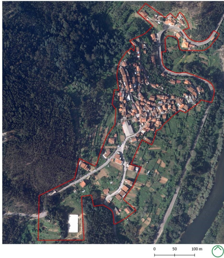
Figura 1 – Limite da Área de Reabilitação Urbana de Foz do Caneiro - ortofotomapa. Fonte: CM Penacova
